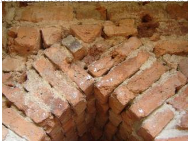
ภาพที่ 42 การก่ออิฐค้ำยันปรางค์ประธานวัดวรเชตุเทพบารุง
