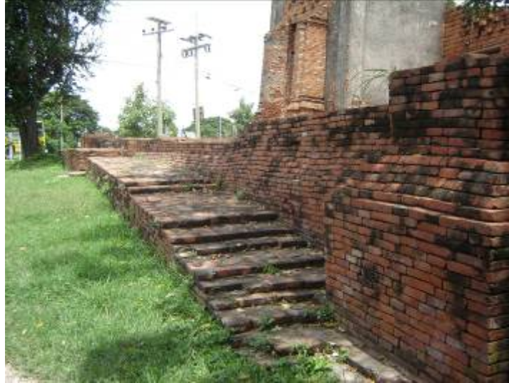
ภาพที่ 276 แนวกำแพงแก้วด้านทิศตะวันตกของวัดวรเชตุเทพบารุง เห็นได้ว่าการก่ออิฐเสริม
