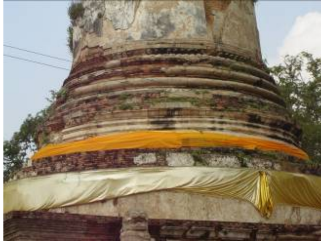
ภาพที่ 208 ส่วนฐานในผังกลมและมาลัยเถารองรับองค์ระฆัง เจดีย์ประธานวัดแม่นางปลื้ม
