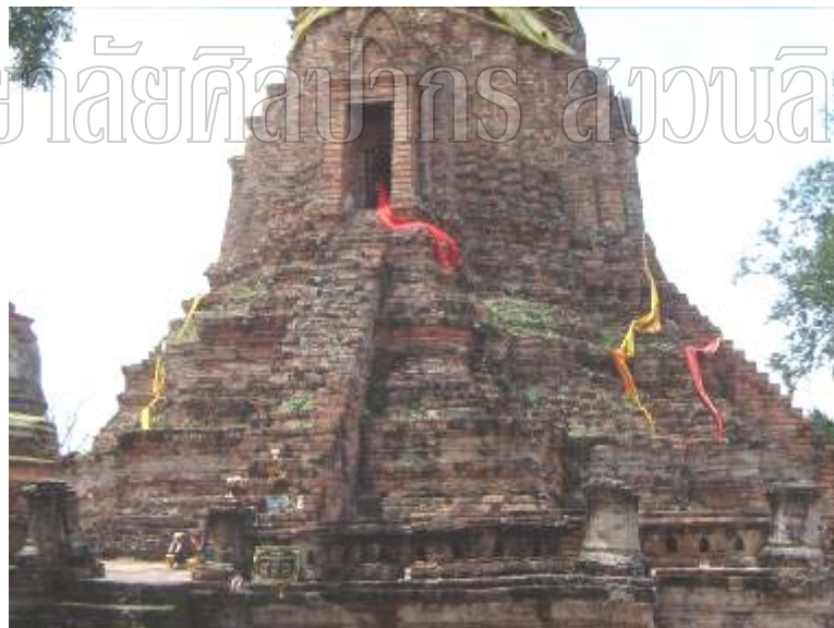
ภาพที่ 51 ฐานบัวลูกฟักสามฐานรองรับเรือนธาตุของปราสาทประธานวัดวรเชตุเทพบารุง
