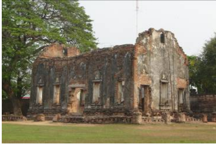
ภาพที่ 223 ตึกพระเจ้าเหา ในพระนารายณ์ราชนิเวศน์ ลพบุรี เป็นอาคารที่สร้างขึ้นโดยได้รับวิทยาการจากชาวตะวันตกในสมัยอยุธยาตอนปลาย โดยมีรูปแบบ สำคัญคือผนังก่ออิฐหนารองรับน้ำหนักเครื่องบน เจาะหน้าต่างเป็นช่องกว้าง
