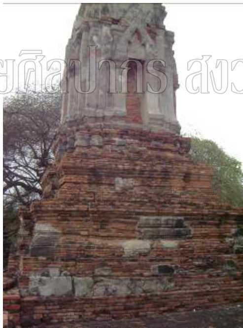
ภาพที่ 128 ชุดฐานบัวลูกฟ้ารองรับเรือนธาตุ เจดีย์ทรงปราสาทยอดประจำมูฐานไฟที่ ปรางค์ประธาน วัดพระราม
