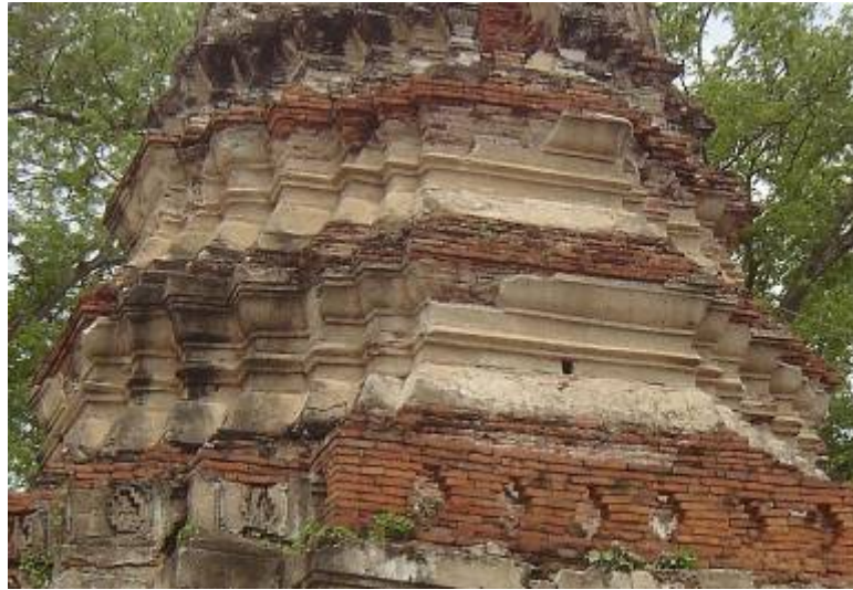
ภาพที่ 127 ชุดฐานบัวลูกแก้วอกไก่รองรับเรือนธาตุเจดีย์ทรงปราสาทยอดวัดวรเชตุเทพบำรุง
