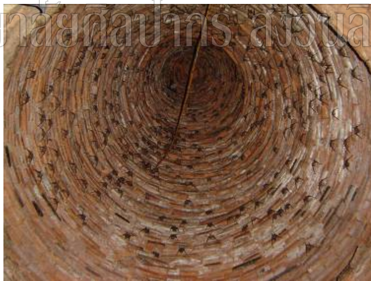
ภาพที่ 46 การทออิฐเป็นคูหากลวงภายในองค์เจดีย์วัดหลังคาขาว อยุธยา
