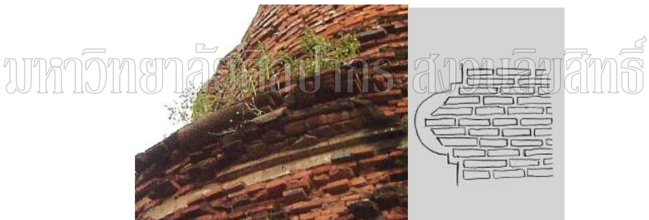
ภาพที่ 183 การก่อชุดฐานรองรับองค์ระฆังแบบ “มาลัยเถา” ของอยุธยา
