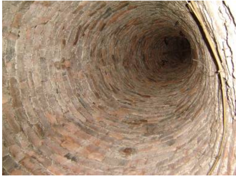
ภาพที่ 45 การทออิฐเป็นโครงสร้างส่วนยอดของปราสาทประธานวัดวรเชตุเทพบำรุง มีการทอเป็นห้องกลวงทรงกรวยแตกต่างจากระเบียบการทอส่วนยอดปราสาทของอยุธยาโดยทั่วไป
