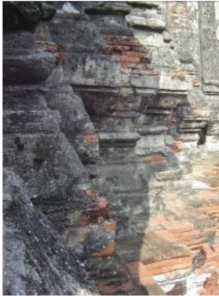
ภาพที่ 63 ฐานเชิงบาตรของปราสาทประธานวัดไชยวัฒนาราม เป็นฐานบัวลูกแก้วอกไก่ แบบเดียวกับปราสาทประธานวัดวรมหาเจดีย์เมืองจำรุง
