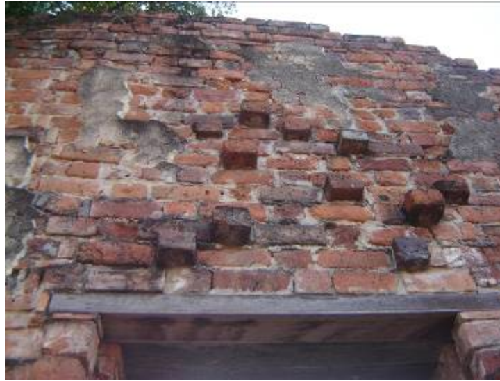
ภาพที่ 246 ร่องรอยอิฐก่อเป็นโกลนซุ้ม ประตูด้านทิศตะวันออกฝั่งใต้ อุโบสถวัดวรเชตุเทพบำรุง
