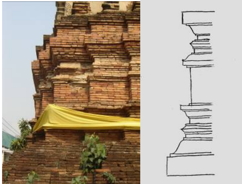
ภาพที่ 57 เหลื่อมท้องไม้เข้าของชุดฐานรองรับเรือนธาตุ เจดีย์วัดบันสาค เชียงใหม่ เป็นระบบการลดเหลี่ยมชุดฐานอีกแบบที่พบในศิลปะล้านนา
