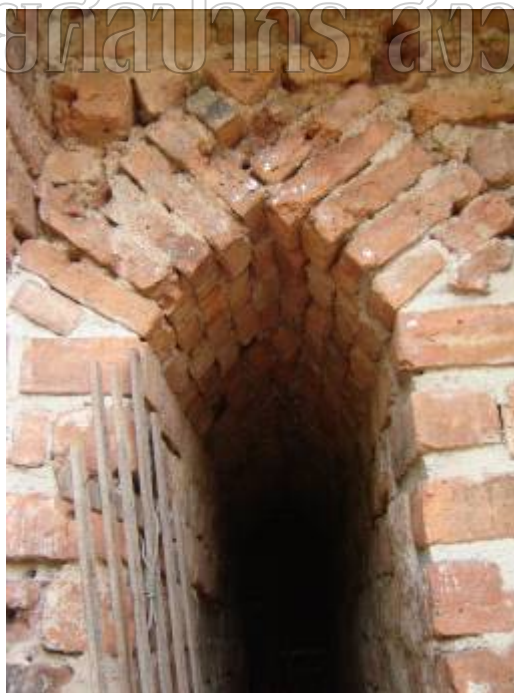
ภาพที่ 35 ทางเข้าคูหาด้านทิศตะวันออกของปราสาทประธานวัดวรเชตุเทพบำรุง มีการก่ออิฐวงโค้งยอดแหลมที่เฉียงขึ้นไปจบกันที่ยอด ต่างจากที่คุ้นเคยกันในงานช่างของอยุธยา
