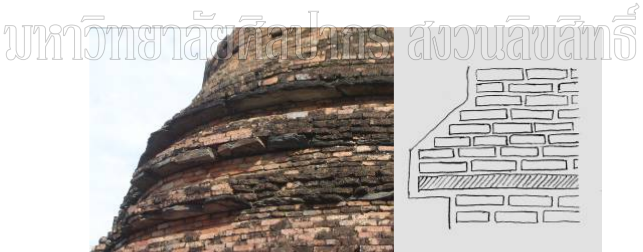
ภาพที่ 182 การก่อชุดฐานรองรับค้ำระฆังแบบ “บัวถลา” ของสุโขทัย
