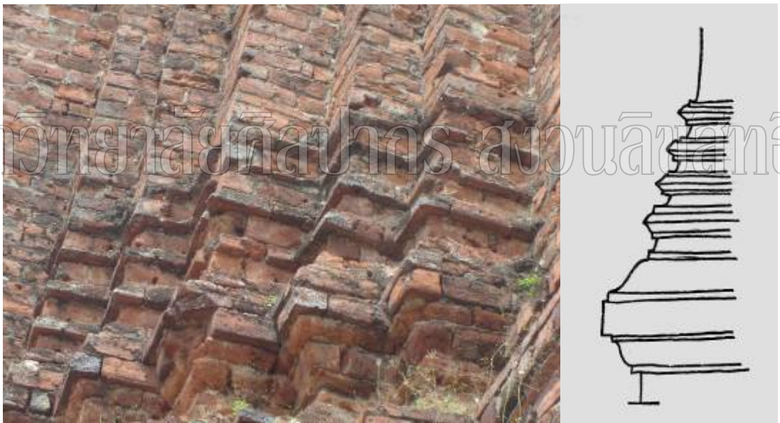
ภาพที่ 71 ลวดบัวเชิงของเรือนธาตุปราสาทประธานวัดวรมหาธาตุกรุงเทพฯ เป็นแถบคิ้วนูนชัดเจน เกิดจากการก่ออิฐให้ยื่นพื้นแนวระนาบของเรือนธาตุและบากเป็นสันคม
