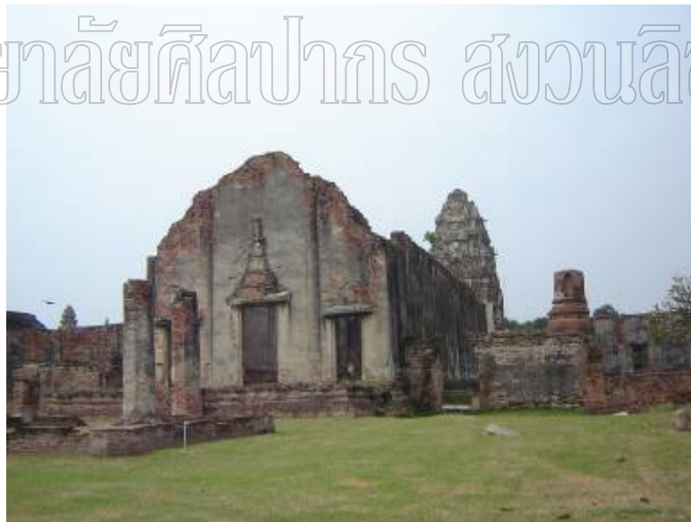
ภาพที่ 224 วิหารหลวง วัดพระศรีรัตนมหาธาตุลพบุรี อาจได้รับการปฏิสังขรณ์ในรัชกาลสมเด็จพระนารายณ์เพราะลพบุรีเป็นเมืองสำคัญในรัชกาลนั้น ผนังก่ออิฐหนามีช่องหน้าต่างรวมทั้งเป็นหน้าจั่วเป็นเครื่องก่อคืออิทธิพลจากศิลปะตะวันตก
