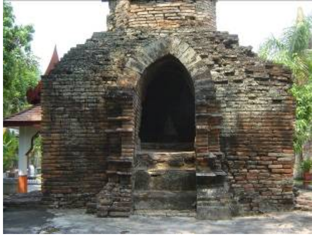
ภาพที่ 40 การก่อคูหาวงโค้งเจดีย์วัดอุโมงค์อารยมณฑล เชียงใหม่ อายุราวพุทธศตวรรษที่ 19 มีการก่อคูหาวงโค้งโดยใช้อิฐหน้าวัวเรียงต่อขึ้นไปบรรจบที่ยอด อัน เป็นกรรมวิธีที่ล้าสมัยรับมาจากศิลปะพุกามของพม่า
