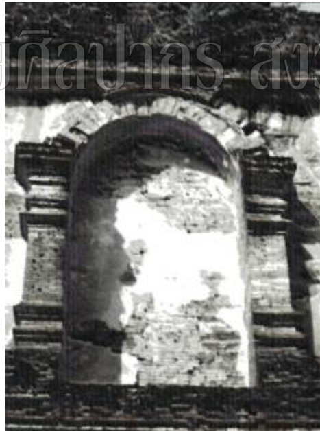
ภาพที่ 41 การก่ออิฐวงโค้ง จระนำเจดีย์ “กูบรจอุฐิพระเจ้าติโลกราช” วัดมหาโพธาราม (เจ็ดยอด) เชียงใหม่
